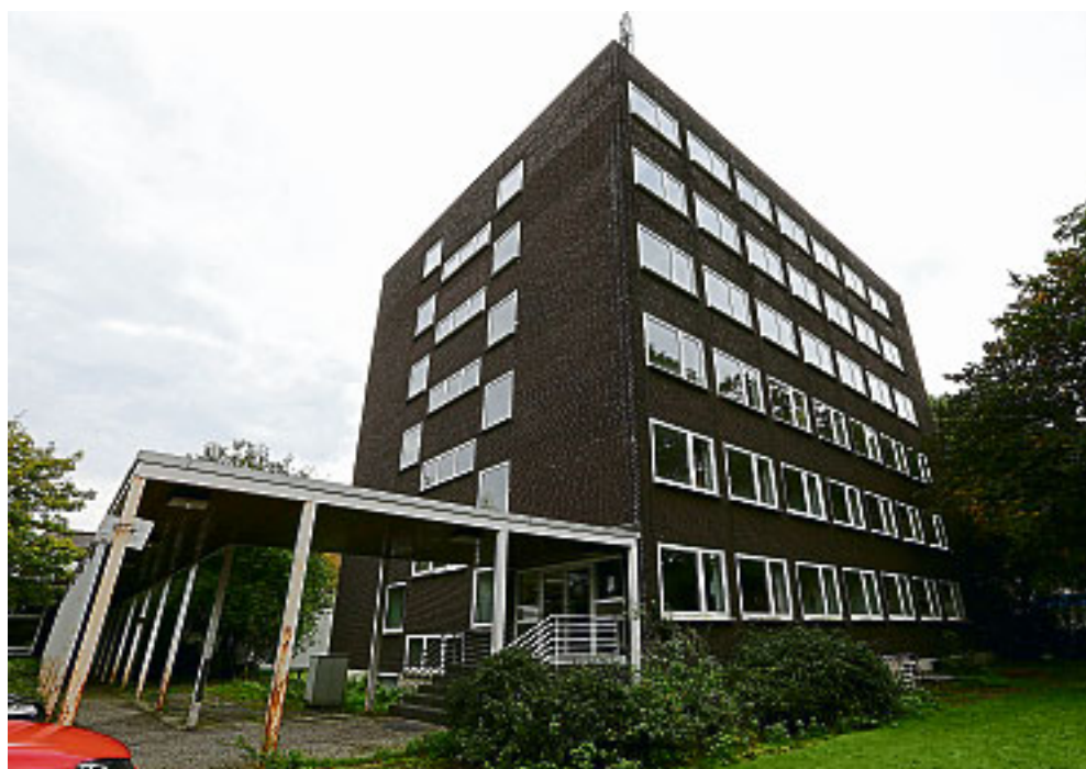
Das alte Henry-Dunant-Haus wird abgerissen. An derselben Stelle entsteht ein neues Studentenwohnheim.
